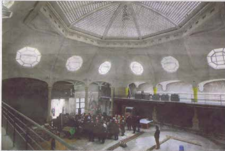
Une visite de chantier ouverte au public était organisée hier en présence de la propriétaire et des architectes. (Photo Thierry David)
